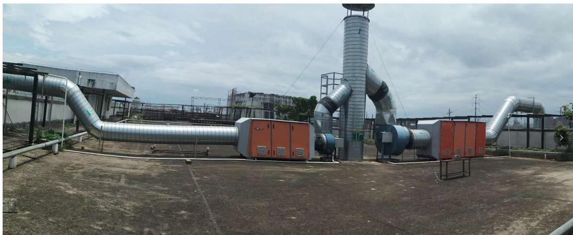
注：企业现设置一根 VOCs 排气筒，未设置其他 VOCs 废气的排放口及出风口
